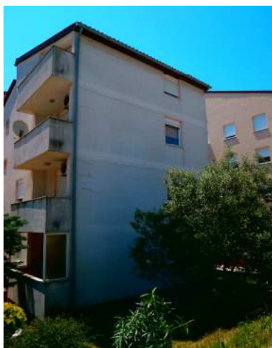
Slika 3. Sjeveroistočno pročelje zgrade
